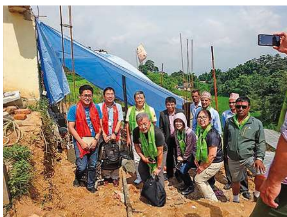
地震で倒壊したトイレの改修工事
